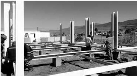
79 Fundaciones e instalación de perfiles para montaje de paneles.
