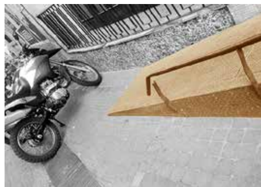
Figura 7: Rampa no cumple los requisitos mínimos, Facultad de Arte Universidad de Chile.
