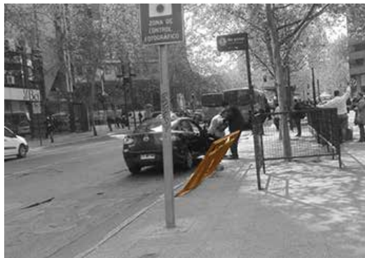
Figura 14: Déficit de mantenimiento en infraestructura vial.
