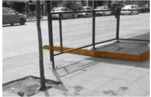
Figura 11: Paradero sin rampa de acceso en Nueva Providencia.
