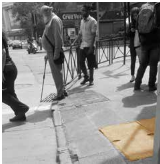
Figura 4: Interrupción de la rampa por tapas en Nueva Providencia.
