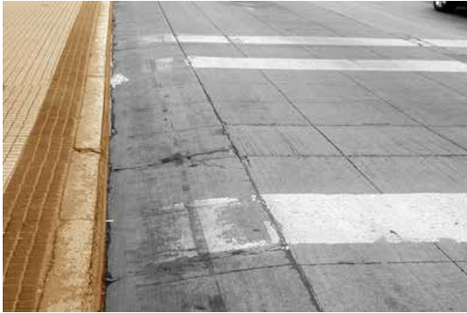
Figura 9: No hay bajada de vereda en cruce Alameda con Portugal.
