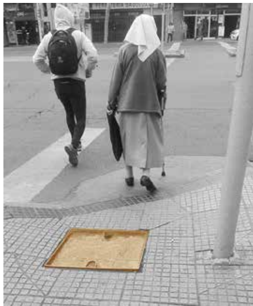
Figura 18: Cruce calle Portugal- Alameda.
