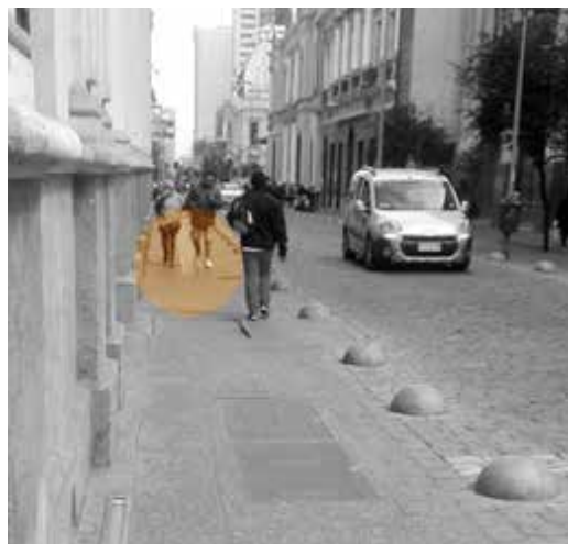
Figura 6: Discontinuidad de huella podotáctil en Calle Compañía con Morandé.
