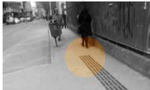
Figura 5: Término anticipado de huella podotáctil en Calle Compañía con Amunategui.
