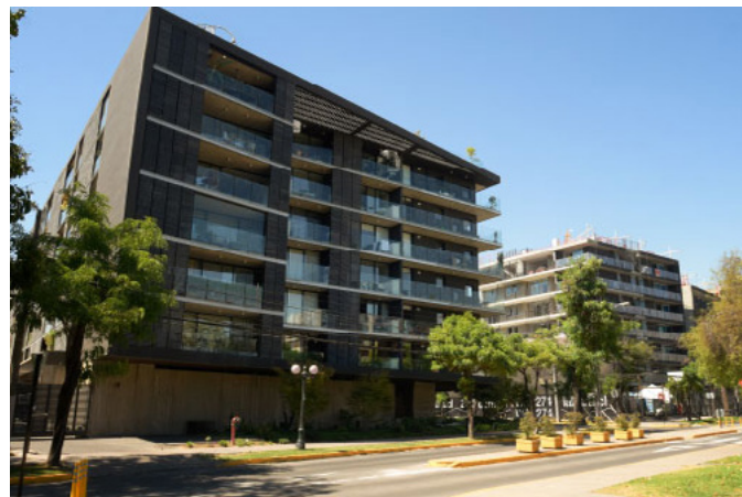
Edificio Willie Arthur de Providencia, de siete pisos. Recibió el Premio al Aporte Urbano 2018 en la categoría Mejor proyecto inmobiliario de altura proyectos de altura media.
