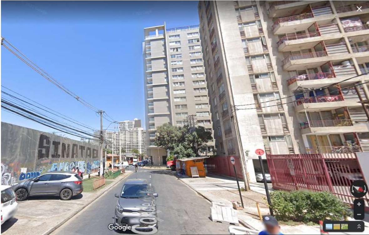
Ilustración 6: Plaza de juegos (vereda izquierda) junto a edificio en construcción y edificios de departamentos en la comuna de Estación Central.
